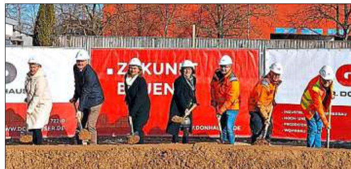
Die Wohnanlage in der Johannisstraße soll vier Gebäude umfassen und insgesamt 33 Wohnungen beherbergen. Am Montag fand der Spatenstich statt. Die Fertigstellung ist für das zweite Quartal im Jahr 2026 geplant.
